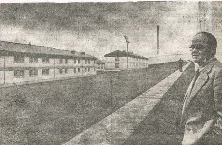
Die neuen zweistöckigen Unterkunftsgebäude der Justizvollzugsanstalt Rockenberg; rechts der stellv. Leiter der Justizvollzugsanstalt, Norbert Müller. (FR-Bild: Schiller)
