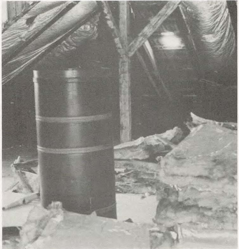
'Großbaustelle Dachboden' - die Arbeit geht voran
