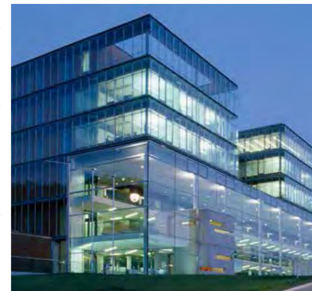
JVA Leoben in Österreich. Sieht aus wie ein nigel-nagelneuer Rechner oder? Das Betriebssystem dazu steht in diesem Artikel - Konzept 2.0
